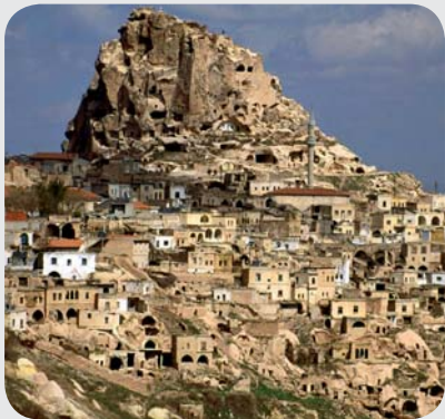
1-CHT- Cases excavades a la roca. Turquia.
